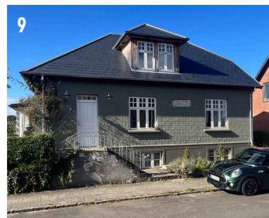
Sjællandsgade 17 En udskiftning af uoriginalt bølgeaternittag til naturskifer-tag giver et eksklusivt og enkelt udseende der passer godt til villaen fra 1905.
