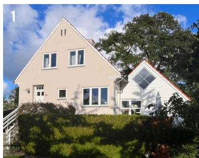
Ahorns Allé 14 Tilbygning i moderne stil som komplimenterer den eksisterende bygning fra 1935.
