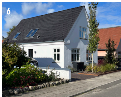
Fynsgade 25 En tilbygning i form af forlængelse af det oprindelige hus fra 1929, med fokus på at bevare sammenhængen med naboejendommene.
